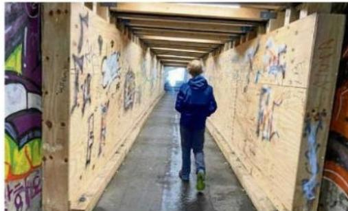
**Der provisorisch mit Stützen (hinter der Verkleidung) verstärkte Durchgang an der Goldbergrampe. Radfahren ist hier nicht mehr möglich – aber oft zu sehen.**
