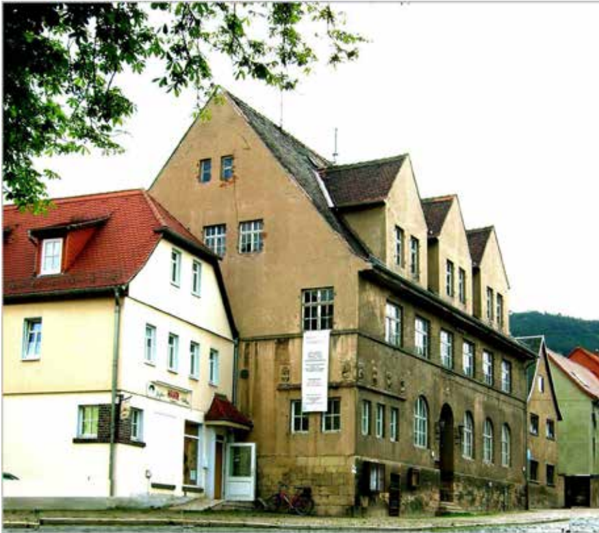
Das Haus vor der Sanierung im Jahr 2010
